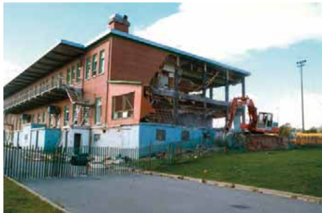
Démolition du Patro de Charlesbourg, 1989-1990
