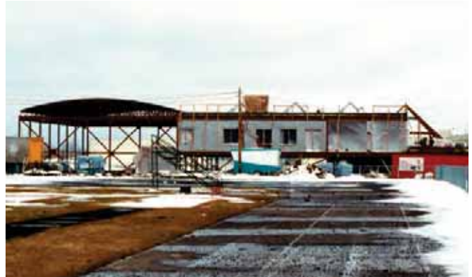
Construction du nouveau Patro de Charlesbourg, 1990
