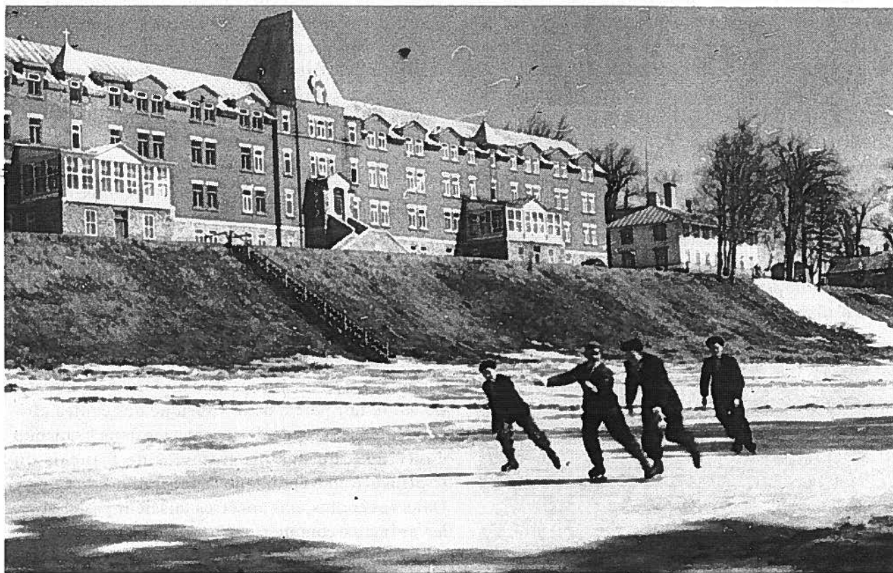
Les édifices de la côte Sainte-Marie
